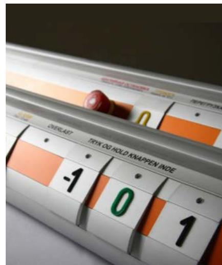
Figura 6 Os botões de comando dos *homelift* têm, em geral, uma configuração que facilita a utilização por pessoas em cadeira de rodas.
