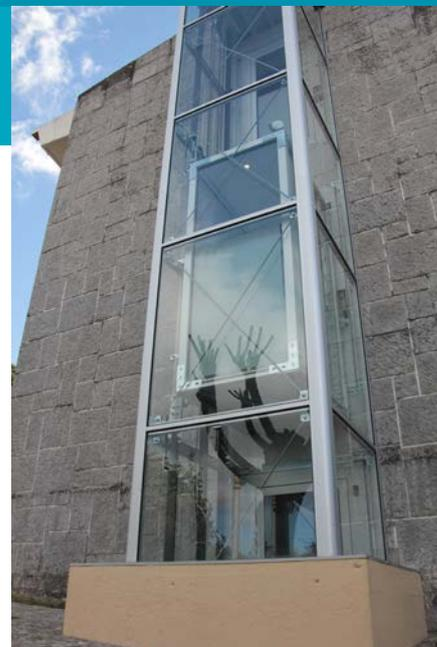
Figura 2 Homelift com acionamento hidráulico aplicado na fachada de uma moradia.
